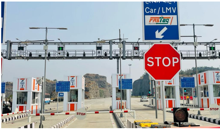
Actual Image – Mumbai Trans Harbour Link Toll Plaza
